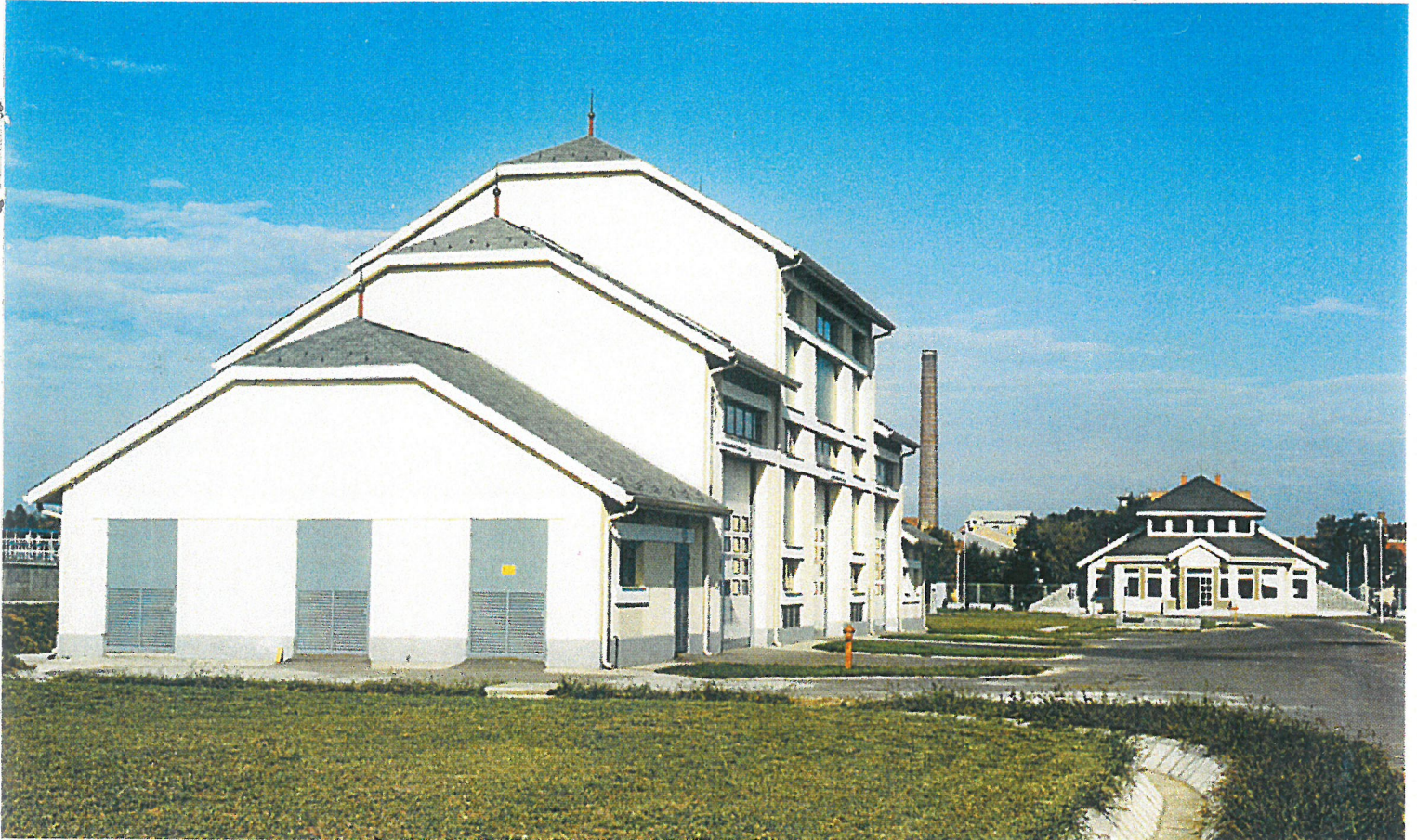
Gépház és üzemviteli épület
