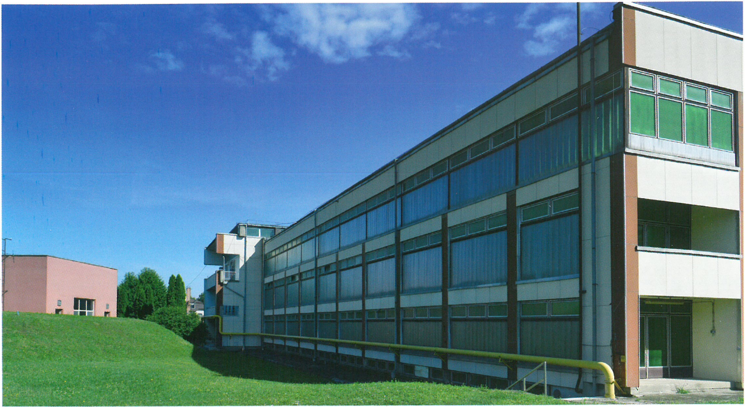
Hálózati szivattyúgépház és szűrőház
